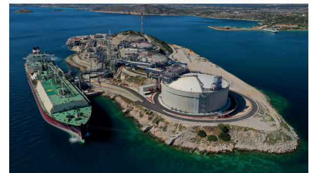
LNG transfer Elefsina LNG Terminal Greece
