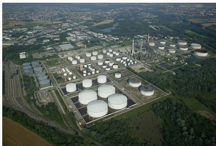
Ingolstadt Refinery in 2005 (copyright Bayernoil Raffineriegesellschaft GmbH).
