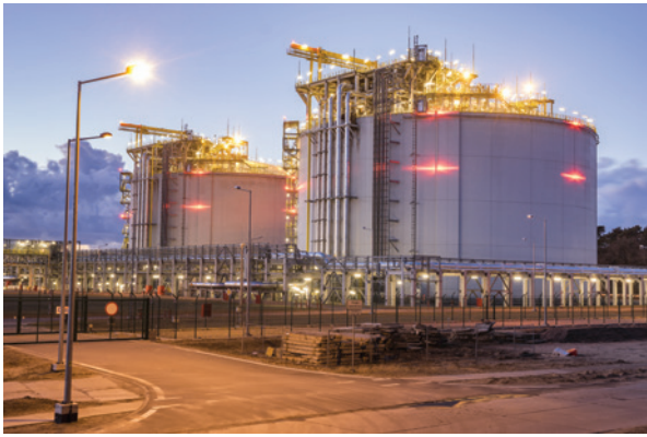
LNG storage terminal
